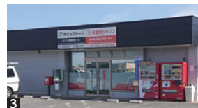
1 施工現場は福岡県全域で戸建住宅、アパート、新築マンションと多岐にわたる 2 従業員同士の仲が良く、風通しの良い社風 3 脊振の山々に抱かれた平成30年に移転した真新しいオフィス
